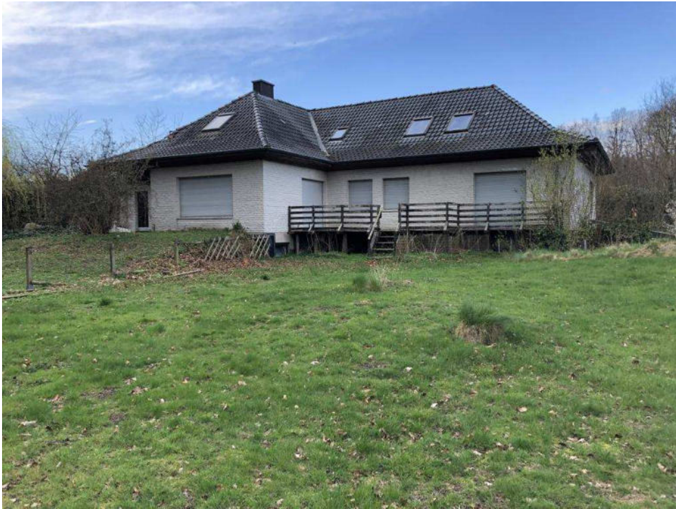
Foto 5: Blick nach NW von Garten aus auf Wohnhaus Am Kiesberg 7 (Aufnahmedatum: 28.03.2024)
