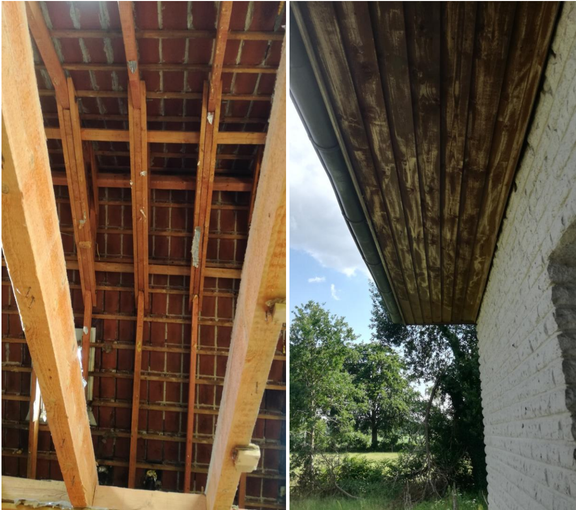
Dachpfannen mit geringer Eignung als Fledermausquartier, Dachunterstand mit Möglichkeit für Fledermausquartiere
