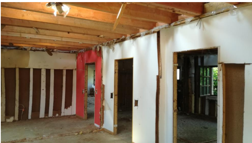
Wohngebäude mit Leichtbauwänden und einfacher Dacheindeckung
