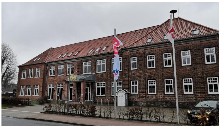
Abbildung 24: Alte Schule Rickling (CIMA 2024)
